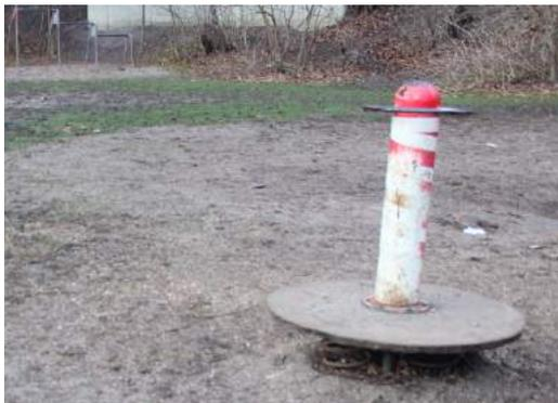
Die Federwippe wackelt, wahrscheinlich durch mangelhafte Fixierung des Fundamentes im sandigen Boden.
