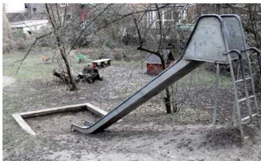
Bei der Rutsche hat sich der Abstand zwischen der Rutschenplattform und der Erdhügeloberfläche im Laufe der Jahre stark vergrößert, so dass sie den aktuellen Sicherheitsanforderungen nicht mehr entspricht und lediglich befristeten Bestandsschutz hat.
