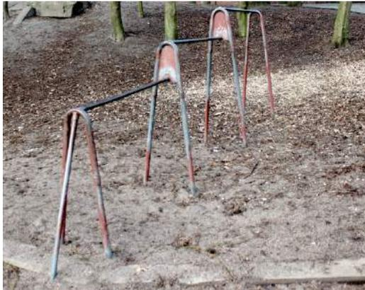
Die Reckstangen sind im Erdreich schon angerostet und müssen in absehbarer Zeit entfernt werden.
